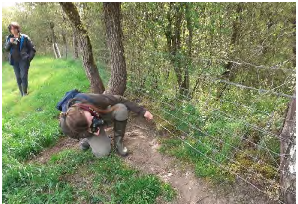
Treillis distendu et trop souple
