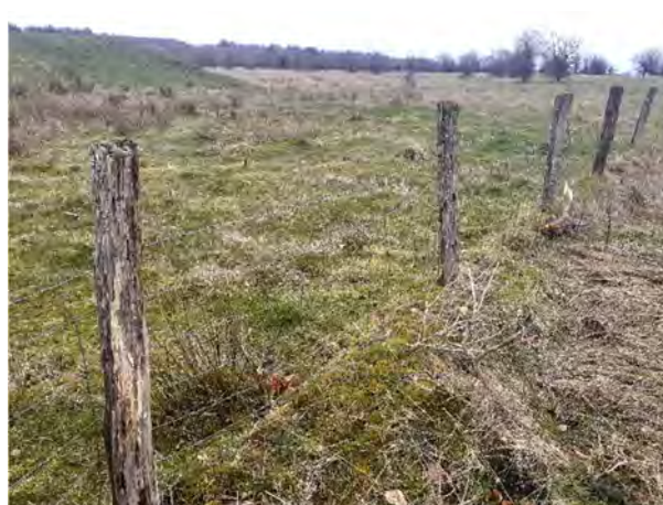
Treillis trop bas (hauteur de 80 cm)
