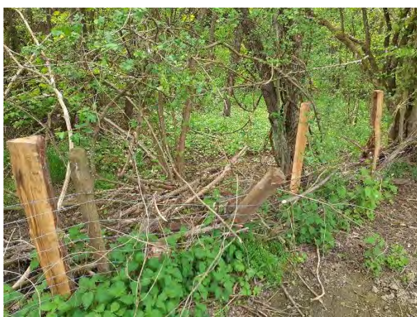
Clôture en mauvais état
